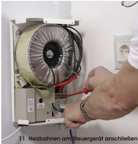
9. Heizbahnen anschließen
